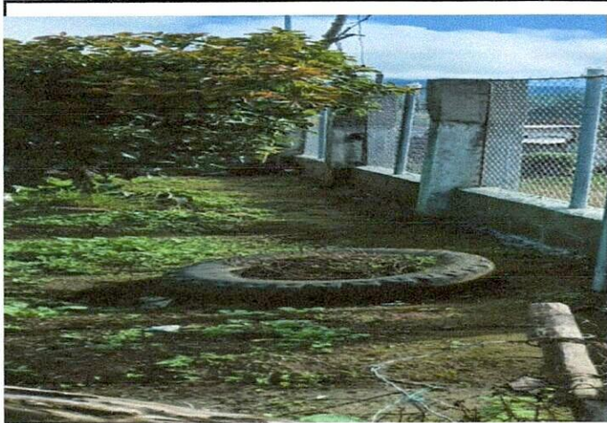
Foto 1: Reparación de muro perimetral con block y malla metálica
