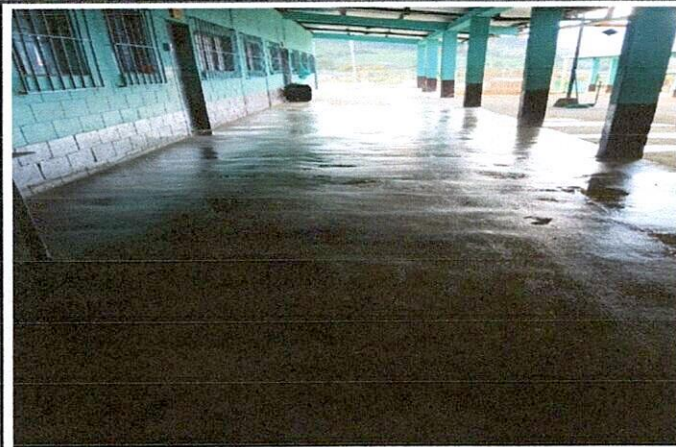
Foto 3: Remodelación del piso de los corredores
