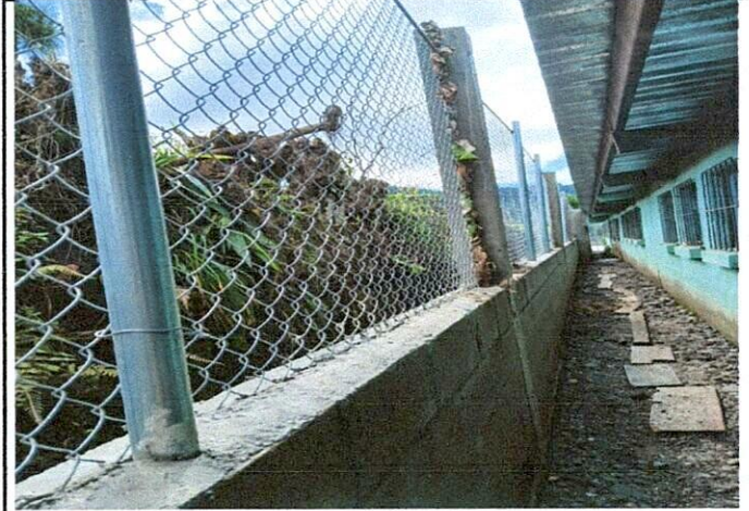
Foto 2: Reparación de muro perimetral con block y malla metálica
