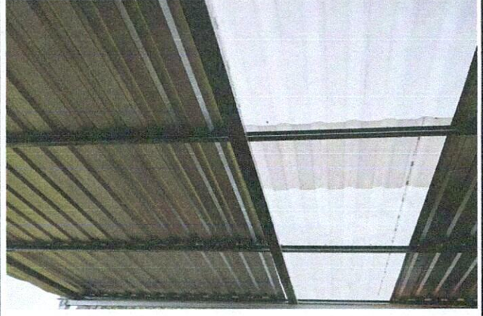
Foto 2: Entechado del área de lavamanos y trapeadores
