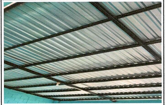
Foto 4: Cambio de techo de un aula
